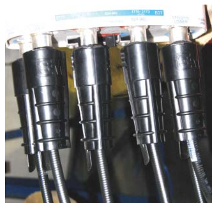
Механическая муфта 3M™ Slim lock на антенне MIMO
